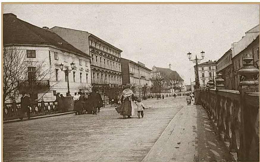
Калиш. Мост через р. Просну. Начало XX в.
