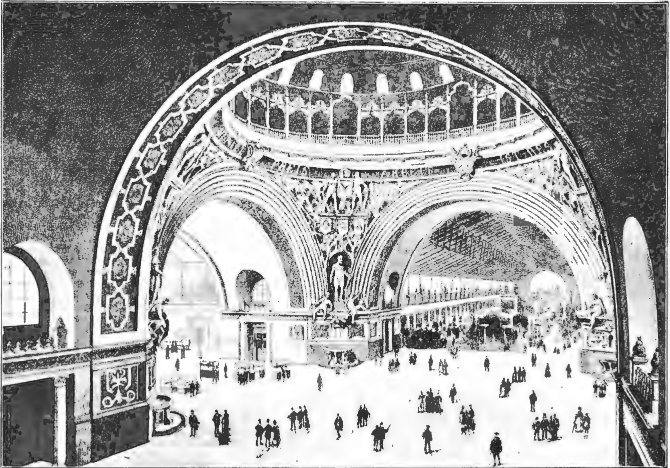
Зала подъ куполомъ при входѣ въ главное здание промышленности.
