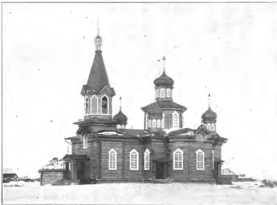
Сооруженіе церквей въ районѣ Сибирской жел. д. Церковь въ поселкѣ Дорофеевскомъ, Ноцкетавскаго уѣзда, Анмолинской области. Съ фот. автопортрета „Нивы“.
