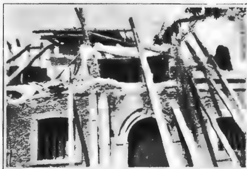
Разрушенный землетрясеніемъ домъ въ Реджіо.
