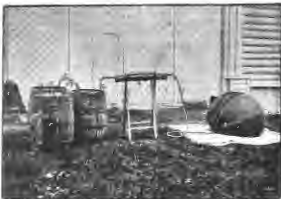
Установка для добывания водорода и наполнение им резинового аэростата-зонда.
