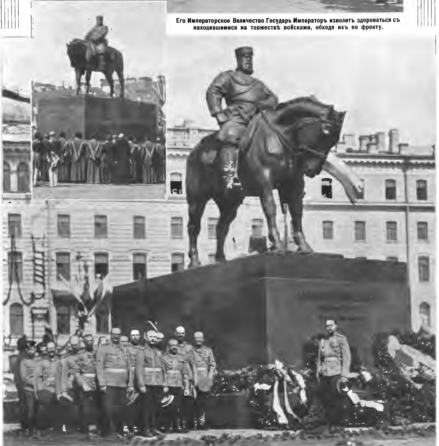
Депутации отъ полковъ, возложившія вѣнки. Памятникъ работы кн. П. Трубецкаго. Пьедесталь памятника—13 аршинъ длины, 5 арш. ширины и 4½ арш. вышины—изъ финляндскаго гранита, конная фигура, отлитая изъ бронзы, вышиною въ 7 аршинъ 6 вершковъ; вѣсомъ въ 500 пудовъ. Стоимость памятника около 1½ милліона руб.
