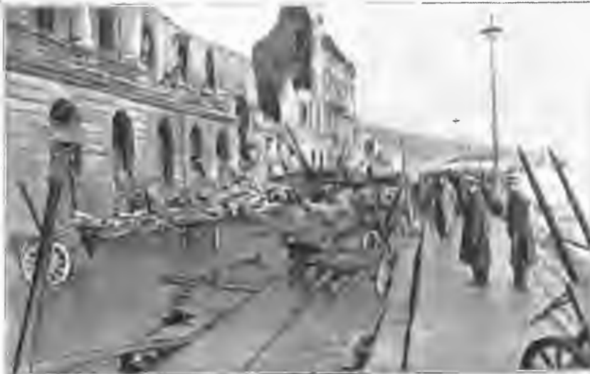
Набережная Мессины „Marina“, загроможденная обломками разрушеннаго землетрясеніемъ дворца „La Palazzata“. Дворецъ отличался великолѣпной архитектурой и былъ построенъ послѣ землетрясенія 1783 г., когда прежнее зданіе было разрушено.
