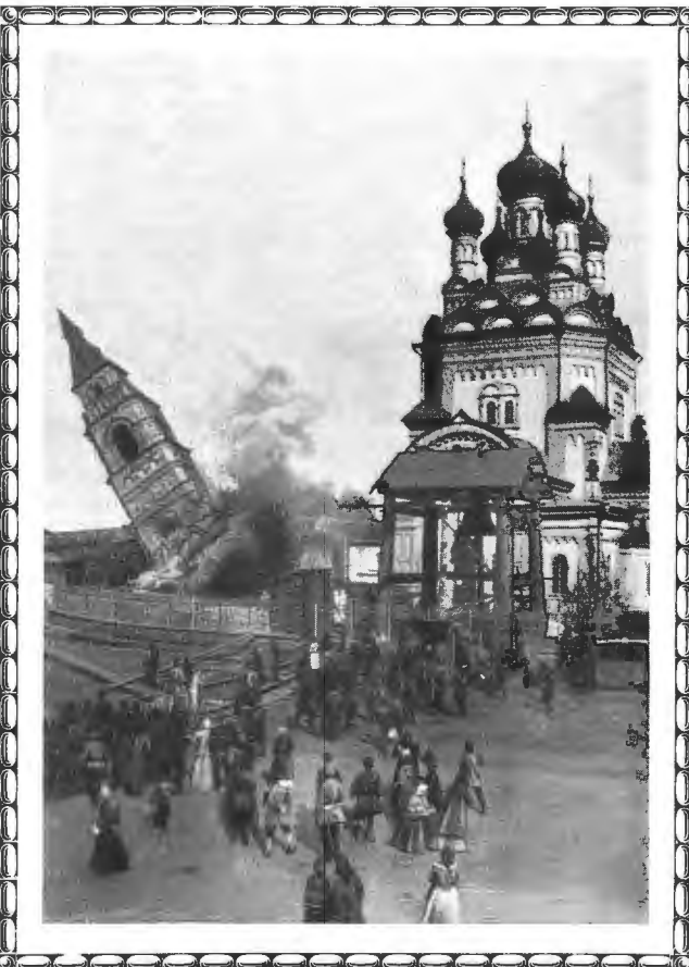
Рѣшивъ перестроить каменную колокольню и отнести ее на 10 сажень отъ церкви, которую поставлено было расширить, церковныя власти поручили строителю снести колокольню цѣликомъ: крестъ былъ снятъ, колокольня была поддолблена снизу съ трехъ сторонъ, въ выдолбленныхъ мѣстахъ введены толстыя осмоленные деревянныя подставки, облиты керосиномъ и подожжены. Когда онъ перегорѣлъ, колокольня повалилась. Фотографія снята въ моментъ ея паденія фотографомъ-любителемъ, реалистомъ 4 класса Н. Вахрушевымъ.
