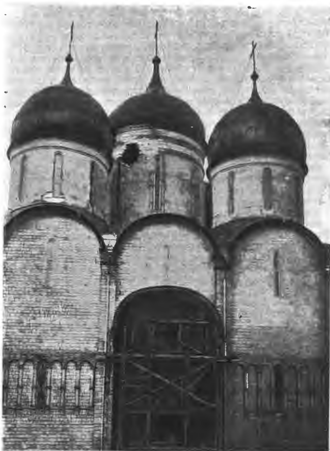
Революція въ Москвѣ. Разрушенія въ Кремль. Пробойна въ стѣнѣ Успенскаго собора, подъ куполомъ.
