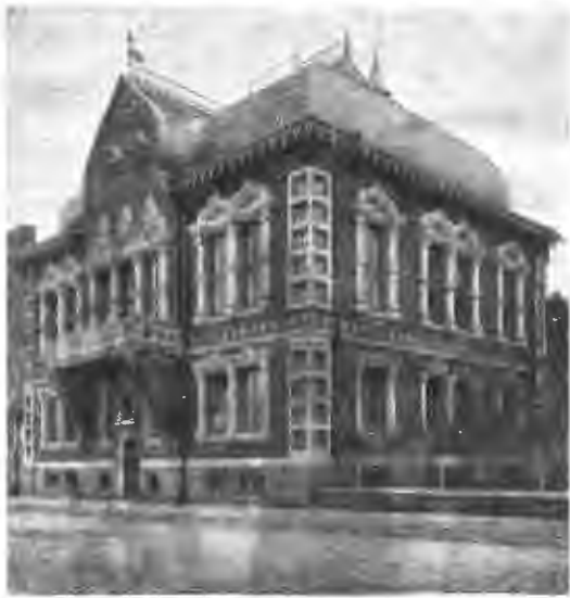
Цвѣтковская галлерея въ Москвѣ, на Пречистенской набережной. Домъ, построенный И. Е. Цвѣтковымъ по рисунку В. М. Васнецова и подаренный городу вмѣстѣ съ галлереей.
