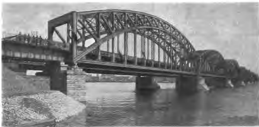
Новый желѣзнодорожный мостъ черезъ Западную Двину въ Ригѣ, открытый весной с. г. Мостъ имѣетъ въ длину 400 саж., онъ арочной системы и состоитъ изъ 9 пролетовъ. Стоимость его около 6 мил. руб. По фот. Н. Т. Миронова, въ Полодкѣ.
