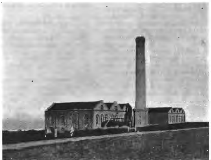
Рис. 4. Заводъ в Сангаттѣ, который обслуживал работы по бурению пробной галереи, прорытой в 1883 году.
