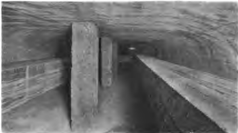
«Висячій домъ» Видъ колодца сверху; по обѣимъ сторонамъ его видны опущенныя въ него колонны. По фот. С. Левковича, въ Парижѣ.
