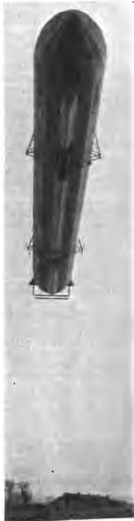
Первый французскій дирижабль „Шписсъ“ (Spiess) твердаго типа, на подобіе нѣмецкаго Цеппелина, сооруженный Обществомъ „Зодиакъ“ и носящій имя своего строителя эльзасца М. Шписса, перваго пропагандиста во Франціи твердой системы дирижаблей. Дирижабль „Шписсъ“—110 метровъ длины и 13 1/2 метр. ширины, емкостью—12.000 куб. метр., снабженный четырьмя пропеллерами, размѣщенными съ обѣихъ сторонъ, и моторомъ въ 360 лошадиныхъ силъ—произвелъ свой первый полетъ съ аэродрома въ Сень-Сиръ, близъ Парижа, облетѣлъ Парижъ и вернулся въ свой ангаръ черезъ Шалонъ-Медонъ. На нашихъ снимкахъ изображены начало полета „Шписса“ и спускъ его на аэродромъ въ Сень-Сирѣ.
