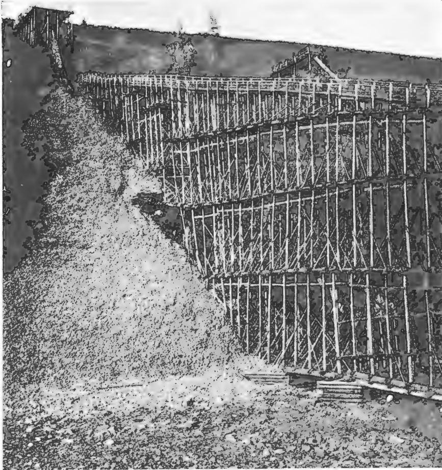
Прискъ Сисина по рѣчкѣ Хомолхо. Сооруженіе для спуска золотоносныхъ песковъ съ горы для промывки.
