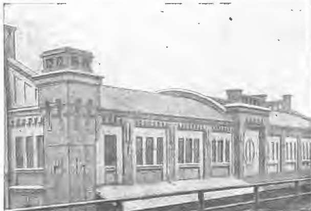
Крыша Сахарн. Склада пакгауза Ю.-З. ж. д., станція Одесса-портъ, крытая Руберойдомъ.
