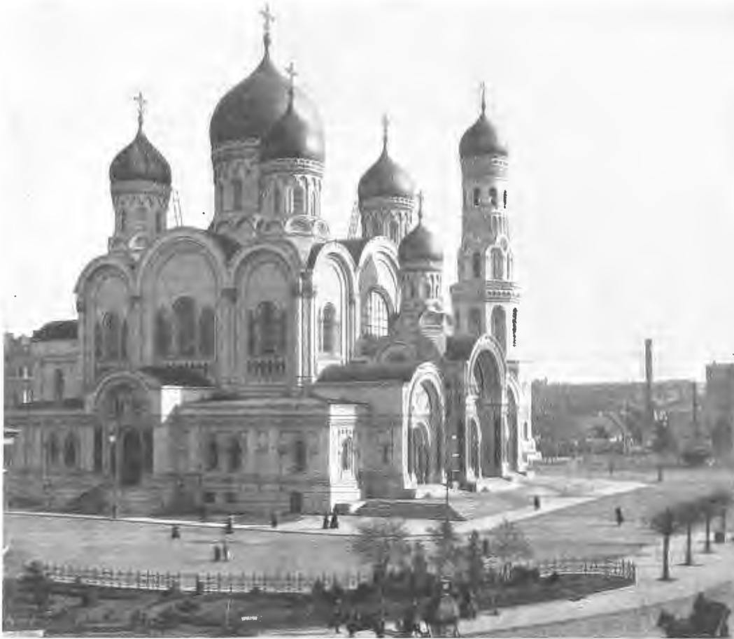
Новый православный соборъ во имя св. Благовѣрнаго Князя Александра Невскаго въ Варшавѣ, заложенный въ 1894 г. и освященный весной этого года.
