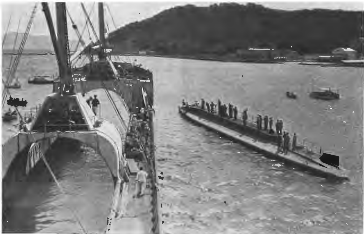
Внутренній бассейнъ транспорта „Кенгуру“, наполненный водою. Подводная лодка передъ впускомъ ея въ транспортъ.
