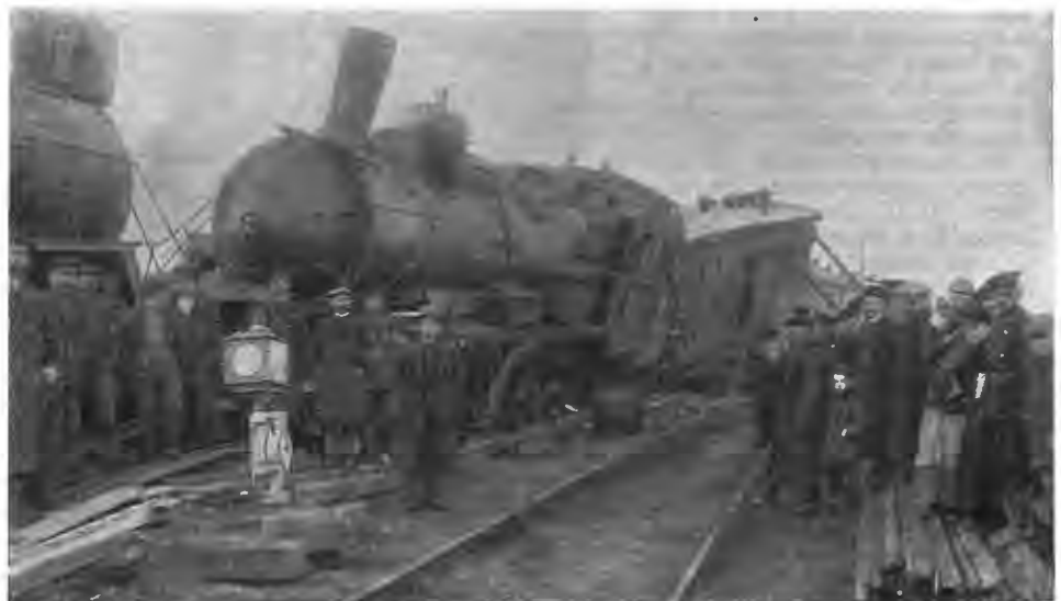
Изогнутые рельсы, разрушенные стрелка и паровоз Киевского скорого поезда, который наскокиль на маневрировавший паровоз. По фот. Я. Штейнберга.
