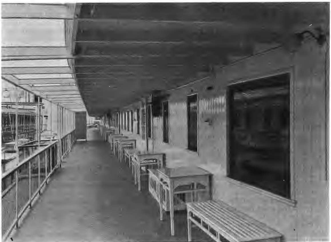
„Теплоходы“. Балконъ I-го и II-го классовъ на теплоходѣ „Бородино“. (Видъ съ носа къ кормѣ).
