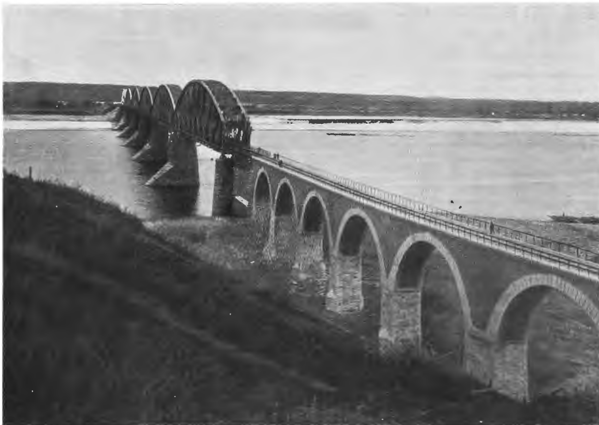
Императорский Романовский мостъ черезъ Волгу у г. Свияжска, торжественно открытый 11 июля с. г. Мостъ состоитъ изъ шести пролетовъ (по 75 саженъ шириною каждый) и береговыхъ устоевъ въ 6 пролетовъ (по 12 саженъ шириною каждый). Общая длина моста—565 саженъ. Стоимость моста—около семи миллионъ рублей. Мостъ построенъ по проекту профессора Н. А. Бѣлелюбскаго инженеромъ Фроловскимъ. По фот. С. Смирнова въ Москвѣ.
