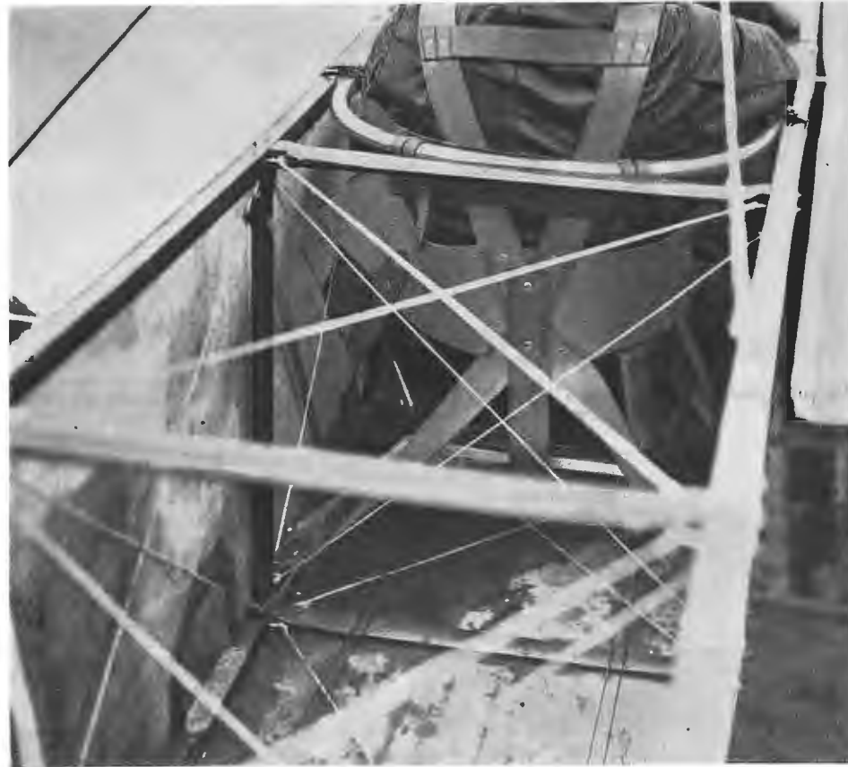
Опыты Пегу. Система прикрѣпленія пилота къ сидѣнью на случай спуска внизъ головою.
