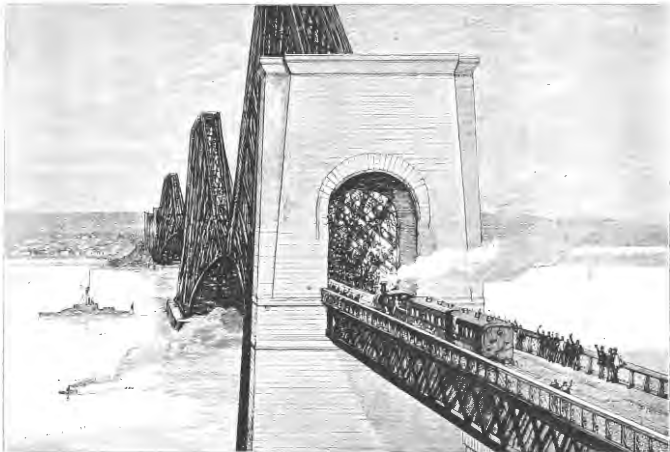
Проходъ перваго желѣзнодорожнаго поѣзда по новому мосту черезъ Фортскій заливъ въ Шотландіи.
