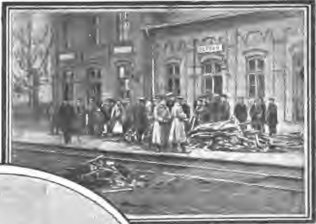
Видъ станціи Рогово послѣ крушенія.
