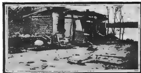
Разрушенный домъ на Михайловскомъ островѣ.
