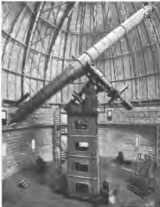
Рис. 1. 40-дюймовый рефракторъ Лерксовской обсерваторіи въ Соед. Шт.
