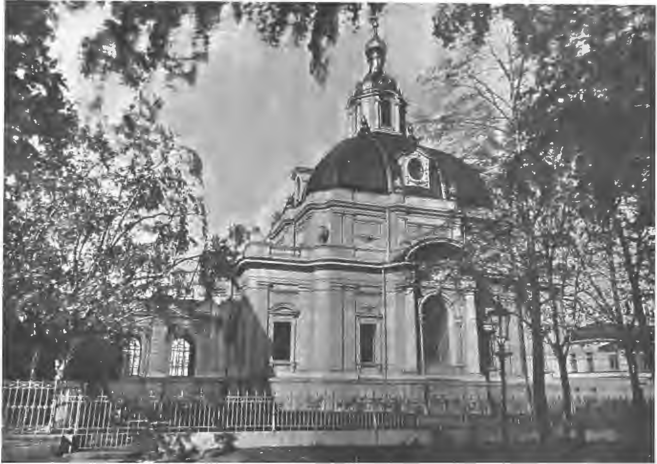
Новая усыпальница Императорской Фамиліи въ Петропавловской крѣпости въ Петербургѣ. Усыпальница находится рядомъ съ сооромъ. Видъ съ боковой аллеи. По фот. Полонскаго, авт. «Нивы».
