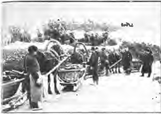
Поперечная разработка выемки въ 2 яруса.
