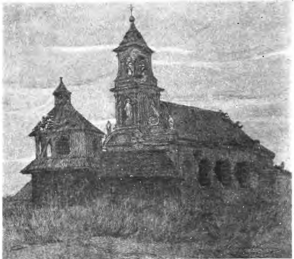
Разрушенный неприятельскими снарядами костелъ.
